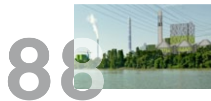
KHKZ Kohleheizkraftwerk Mainz-Wiesbaden Mainz
