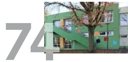
Regenbogenschule und Kita Bauklötzchen Moers
